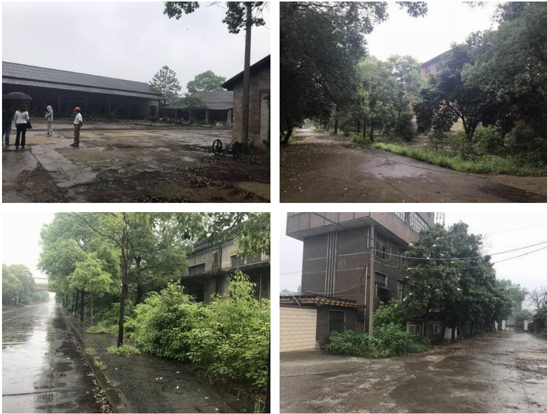
图1 厂区内部分遗留建筑物照片
